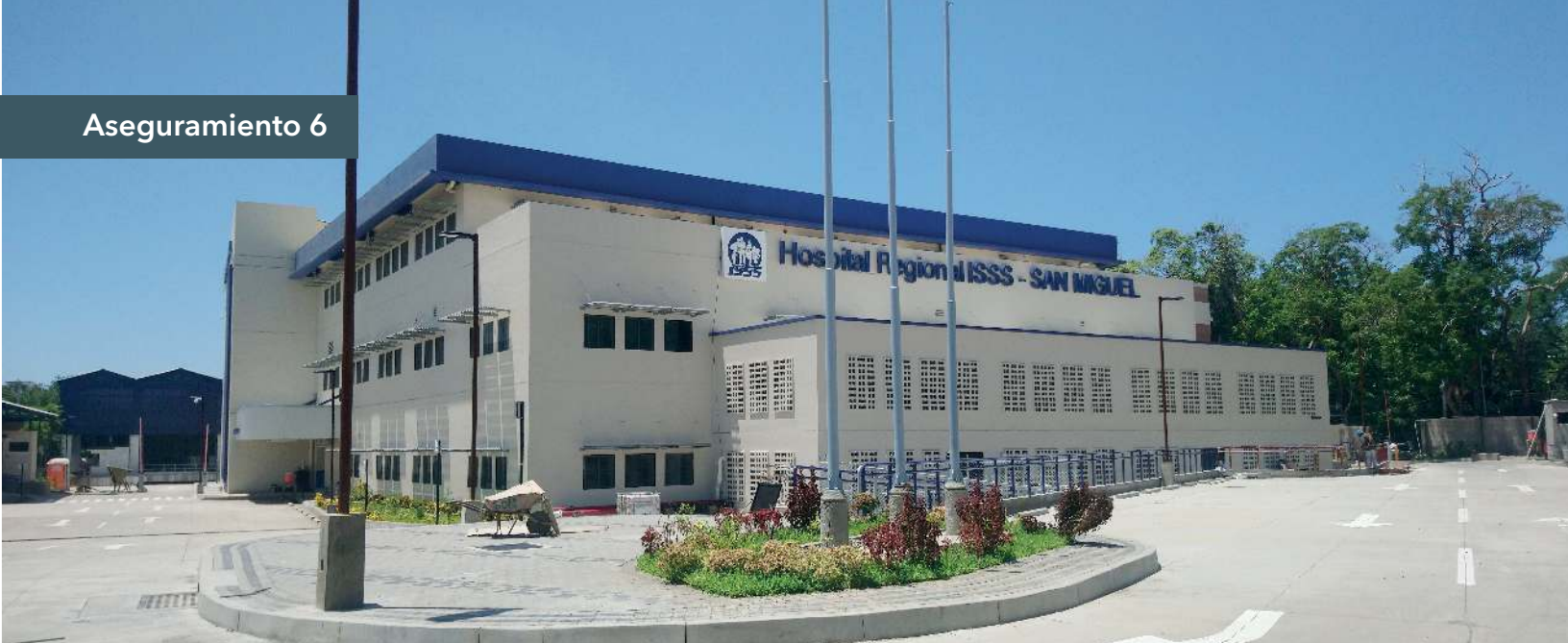
Vista de Fachada Occidente, tomada en visita de campo al proyecto, realizada el 25 de junio de 2019.
