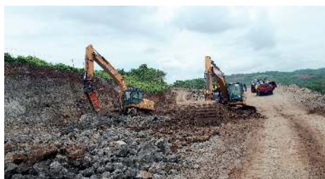
6. Diseño y Construcción del Proyecto: ‘Ampliación de Carretera CA04S, Tramo III: Construcción de By Pass de La Libertad entre km 31.86 (Carretera CA04S)-km 35 (Carretera A02W), Departamento de La Libertad’, Estaciones 2+480 a 4+873.59
