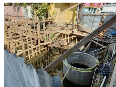
6. Construcción del sistema de tratamiento de aguas residuales, alcantarillado sanitario y obras de adecuación turística en playa El Tunco, municipio de Tamanique, departamento de La Libertad. Monto de inversión: $2,926,295.17
