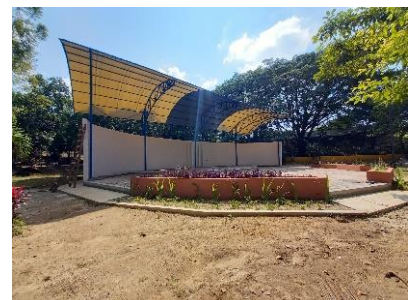
10. Obras de mejoramiento en el estadio Óscar Quiteño, municipio de Santa Ana, departamento de Santa Ana.
