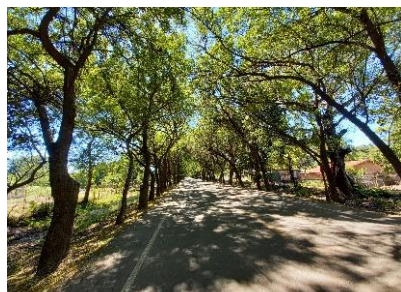
3. Mejoramiento del camino rural USU08S, Tramo CA02E (desvío San Marcos Lempa) – desvío El Zamorán, municipio de Jiquilisco, departamento de Usulután. Monto de inversión: $8,212,317.33
