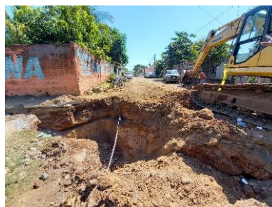
8. Introducción de servicio de aguas negras en colonias Nueva Acajutla y San Emilio, municipio de Acajutla, departamento de Sonsonate. Monto de inversión: $757,365.09
