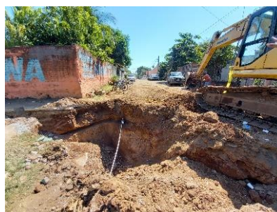
8. Introducción de servicio de aguas negras en colonias Nueva Acajutla y San Emilio, municipio de Acajutla, departamento de Sonsonate.
