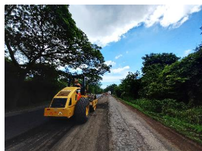
2. Mantenimiento periódico de la ruta CA02W tramo: CA12S-dv. San Francisco Menéndez. Monto de inversión: $6,825,273.13
