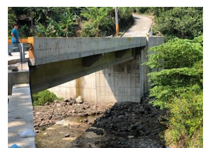
9. Construcción de puente vehicular sobre río Chiquito, en calle hacia caserío El Chuptal, cantón Upatoro, Chalatenango.
