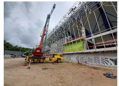
11. Seguimiento del proyecto: Ampliación de la Terminal de Pasajeros del Aeropuerto Internacional de El Salvador San Óscar Arnulfo Romero y Galdámez, Etapa 1.
