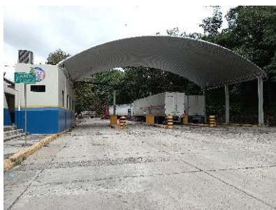
5. Construcción de obras exteriores, adecuación de espacios, equipamiento en aduana terrestre El Poy, municipio de Citalá, departamento de Chalatenango. Monto de inversión: $850,488.93
