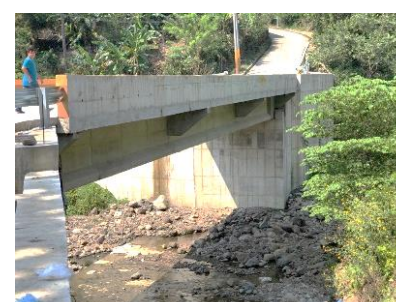
9. Construcción de puente vehicular sobre río Chiquito, en calle hacia caserío El Chuptal, cantón Upatoro, Chalatenango. Monto de inversión: $1,883,323.90
