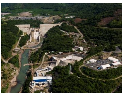
7. Construcción de presa CCR. Proyecto Hidroeléctrico El Chaparral.
