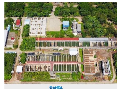
12. Seguimiento del proyecto: Rehabilitación de las Obras de Captación, Potabilización y Electromecánicas de la Planta Potabilizadora Las Pavas. Monto de inversión: $64,781,033.90
