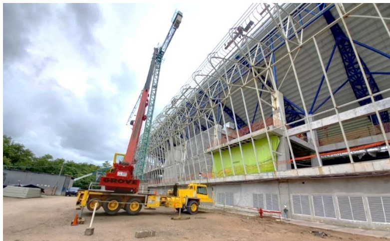
Vista del proyecto “Ampliación de terminal de pasajeros del AIES-SOARG, etapa 1”. Fotografía realizada en visita de campo del Tercer Proceso de Aseguramiento (12 de abril de 2019).
