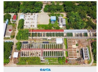
12. Seguimiento del proyecto: Rehabilitación de las Obras de Captación, Potabilización y Electromecánicas de la Planta Potabilizadora Las Pavas.
