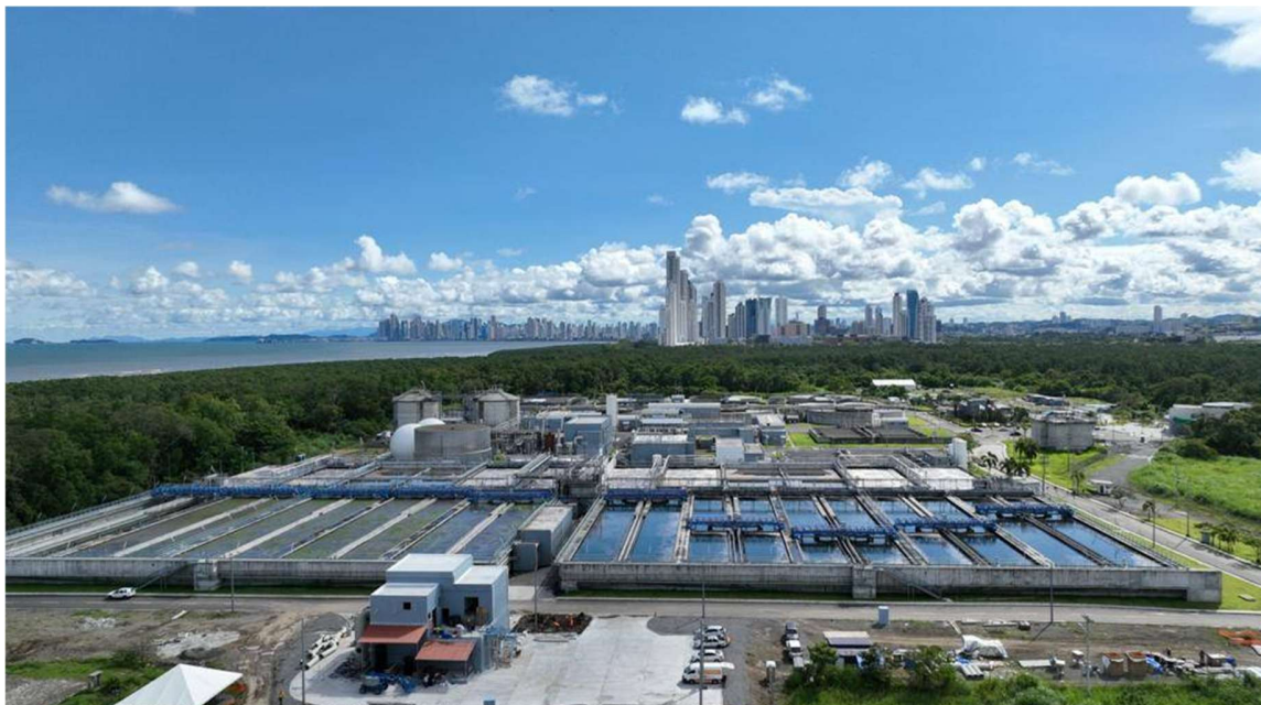
Figura 10. Segundo Módulo de la Planta de Tratamiento de Aguas Residuales de la ciudad de Panamá
