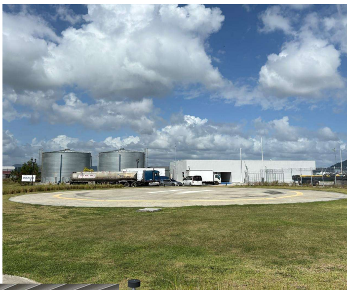
Foto 7. Helipuerto y oficinas
