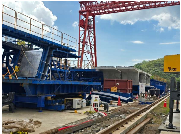
Foto 4. Planta de prefabricado de dovelas para el tablero del puente principal
